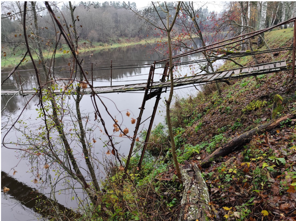
4 pav. Deformuotas, paplautas ir pasviręs pilonas dešiniajame krante.
