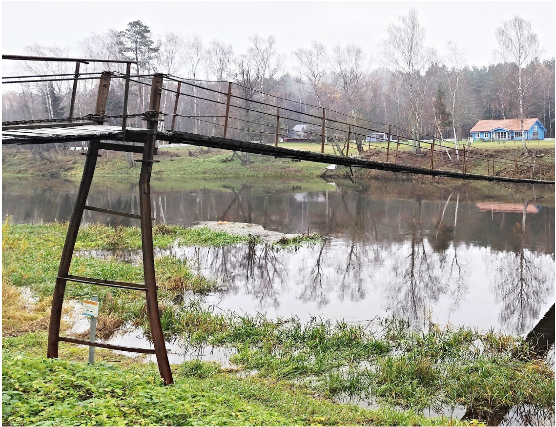
3 pav. Deformuotas ir pasviręs pilonas kairiajame krante.
