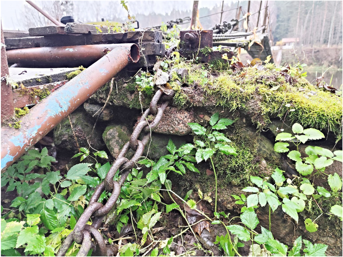
7 pav. Kairiajame krante akmenų-betono atrama aptrupėjusi, viena dalis su kita sujungta grandinėmis, betono kokybė vizualiai neatitinka reikalavimų (dėl įmirkio betono klasės nustatyti nebuvo galimybės).
